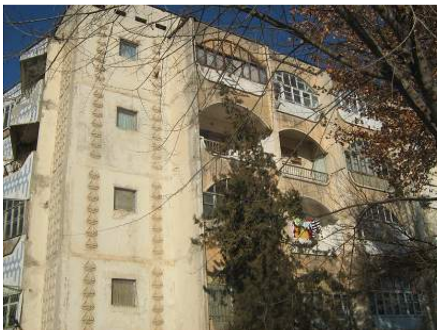
Рисунок 1.3 – Пятиэтажный крупнопанельный жилой дом серии 105 в 12 – м микрорайоне г. Худжанда
