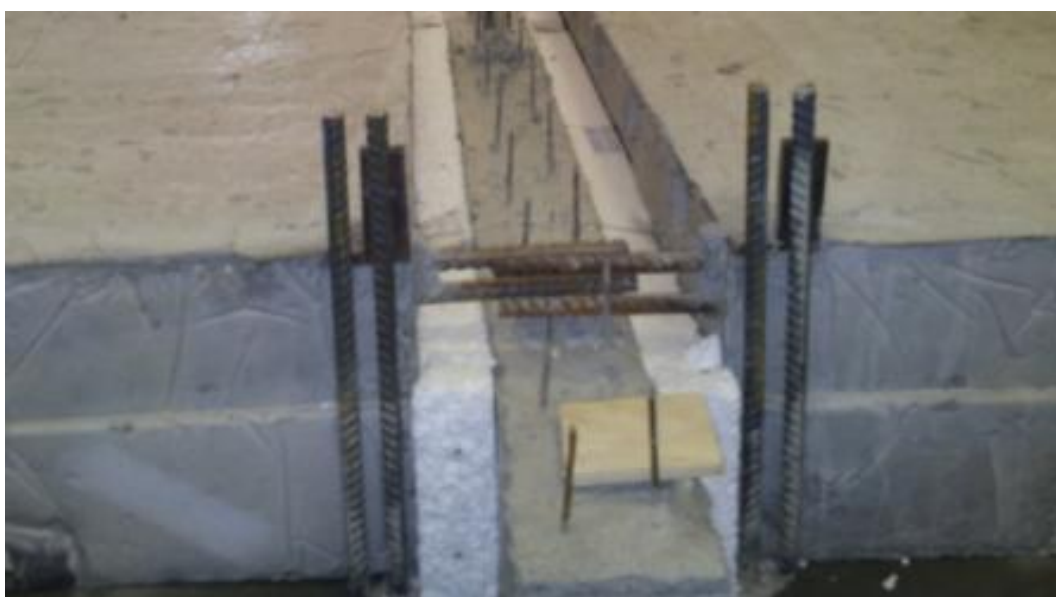
Рисунок 3.21 – Узел сопряжения плит с ригелем
