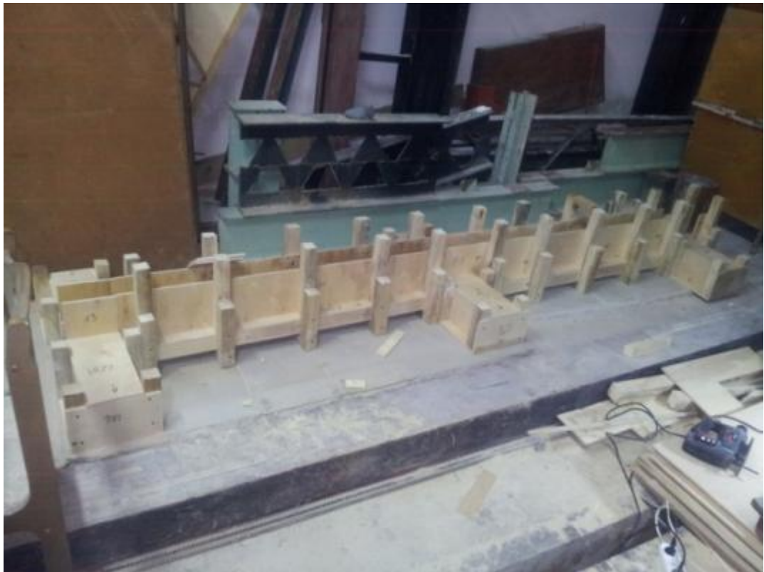
Рисунок 3.8 – Устройство опалубки модели ригеля с опорными стенками
