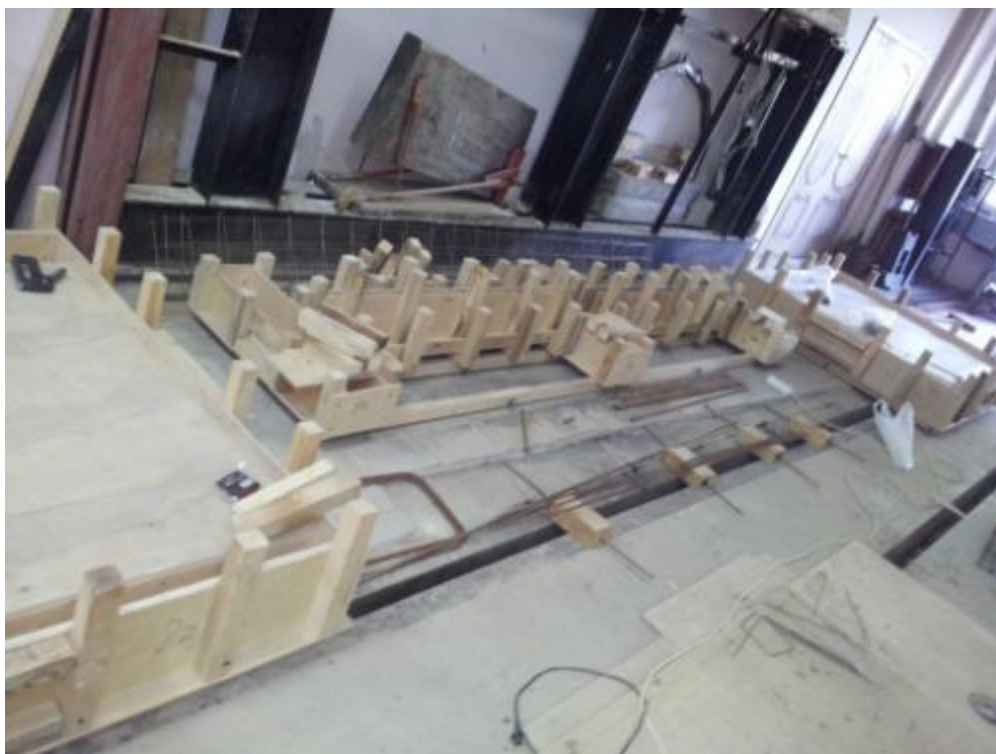
Рисунок 3.1 – Материалы для устройства опалубки плит и ригеля
