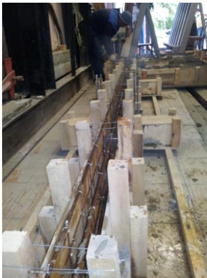
Рисунок 3.17 – Армирование ригеля с опорными стенками
