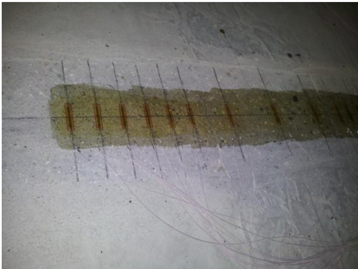
Рисунок 3.24 – Установка тензорезисторов типа 1G3W 120 Ом
