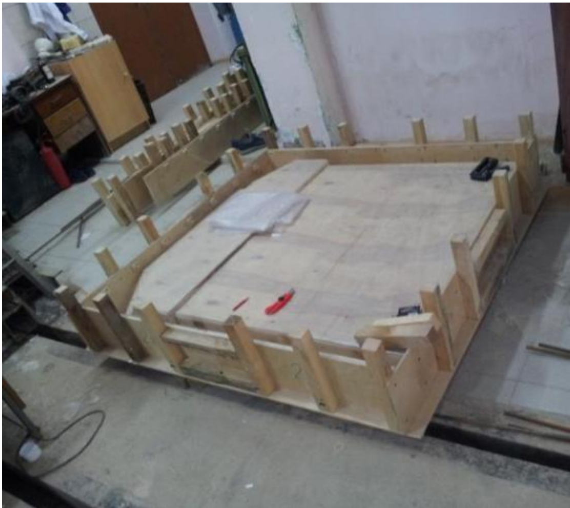
Рисунок 3.7 – Устройство опалубки модели плиты
