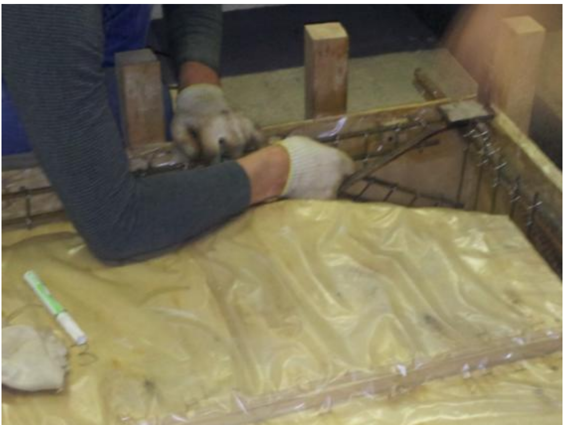
Рисунок 3.15 – Армирование торцевых и продольных ребр плиты
