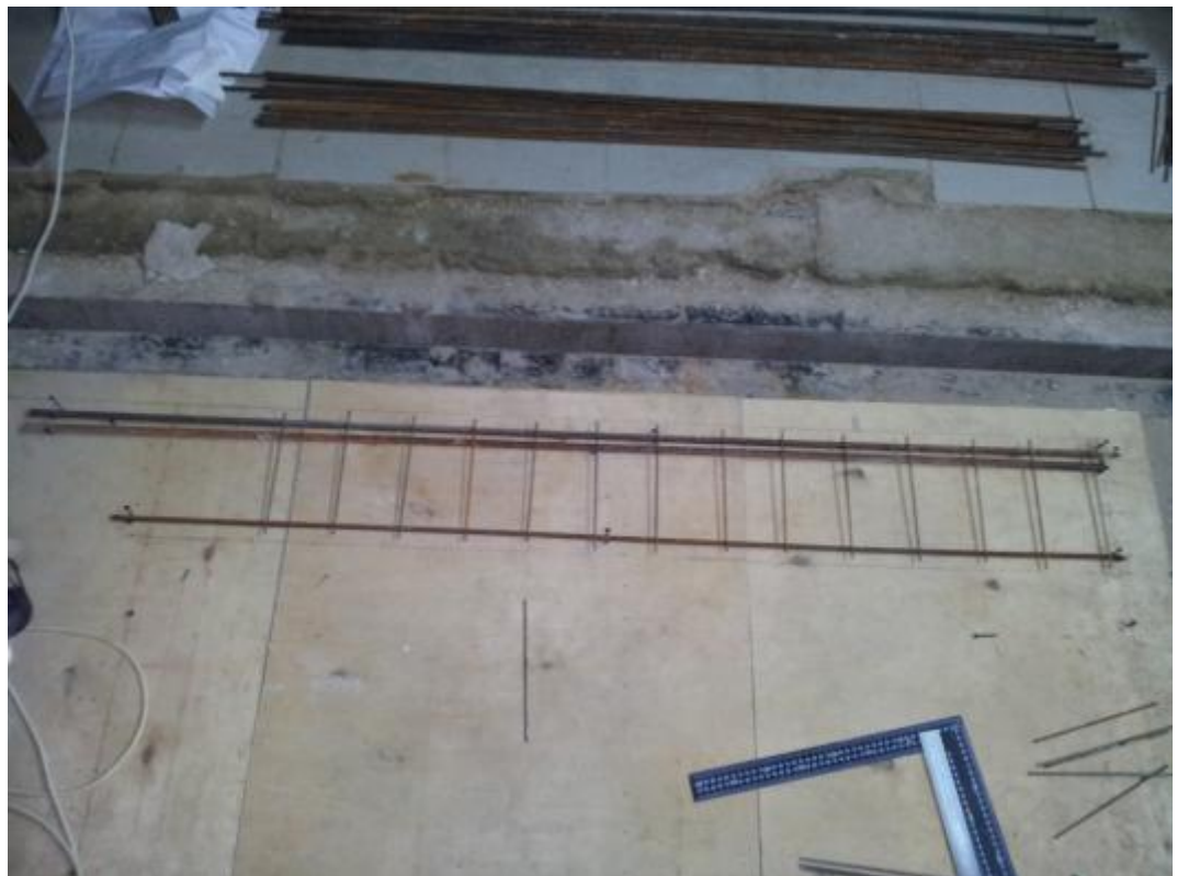
Рисунок 3.9 – Плоский каркас для армирования продольного ребра плиты
