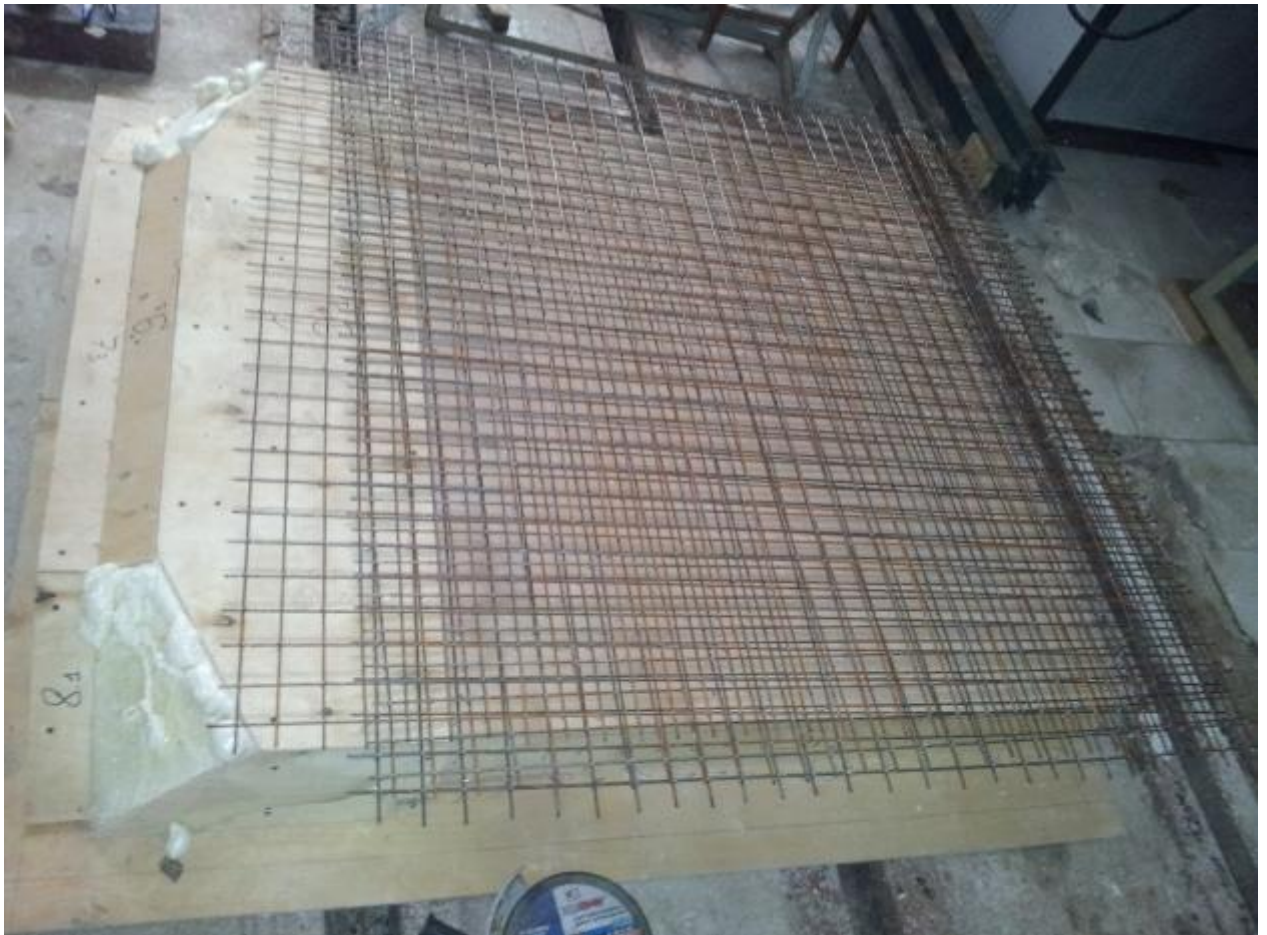
Рисунок 3.10 – Арматурные сетки с ячейками 50x50 мм для армирования полок плит
