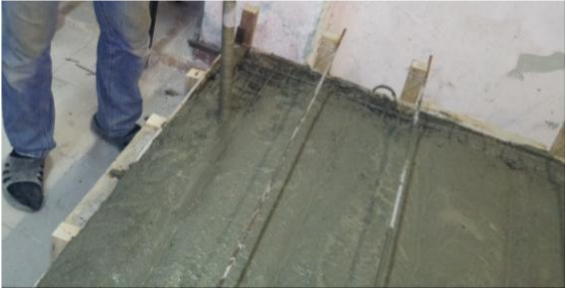
Рисунок 3.18 – Бетонирование плиты с помощью вибратора для уплотнения бетона
