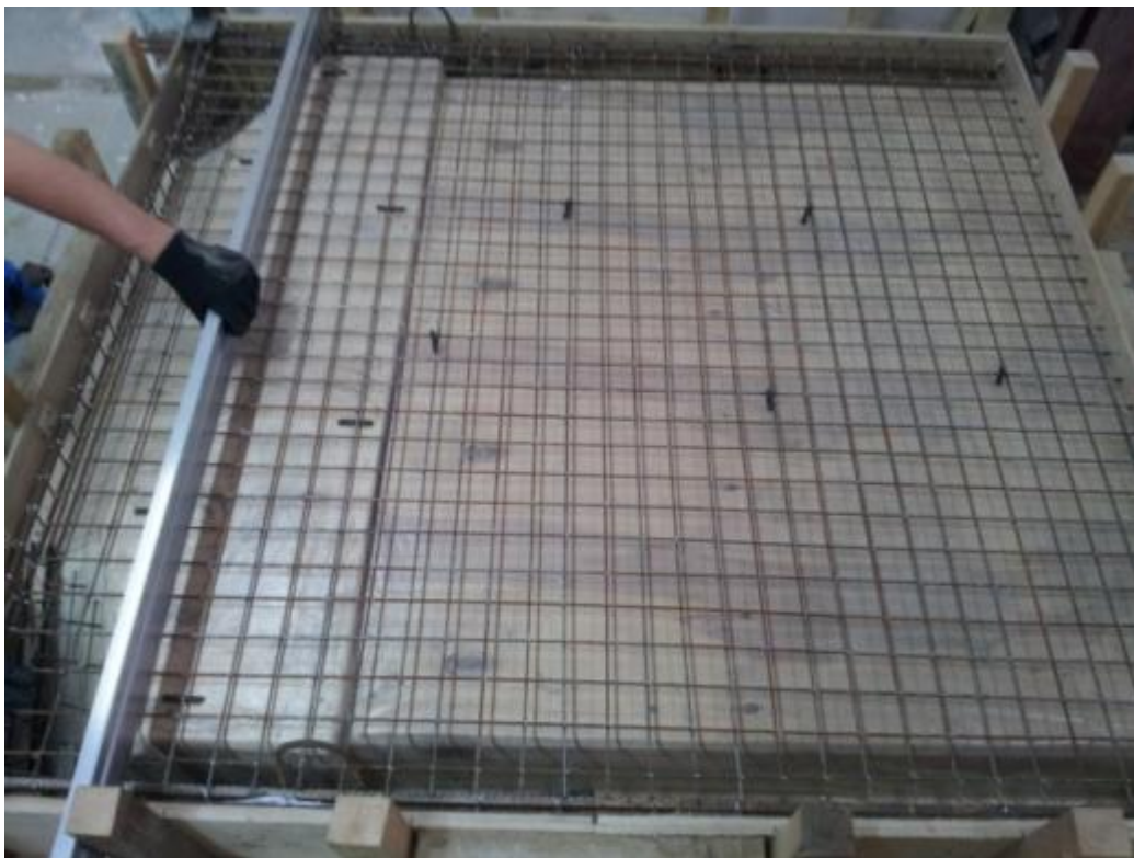
Рисунок 3.16 – Армирование полки плиты
