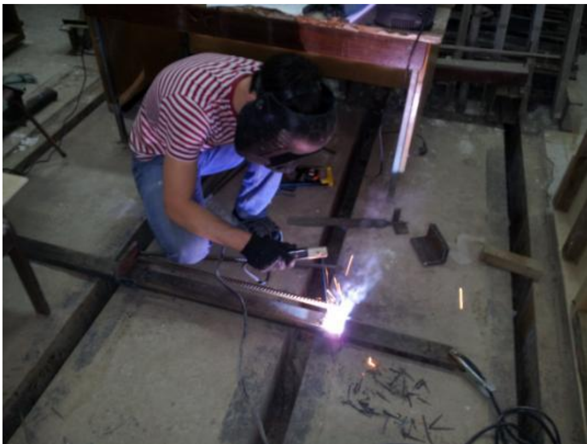
Рисунок 3.12 – Сварка элементов пространственного каркаса опорных стенок ригеля
