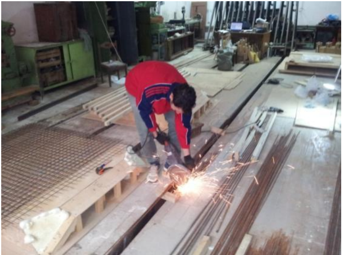
Рисунок 3.14 – Работы по изготовлению арматурных изделий
