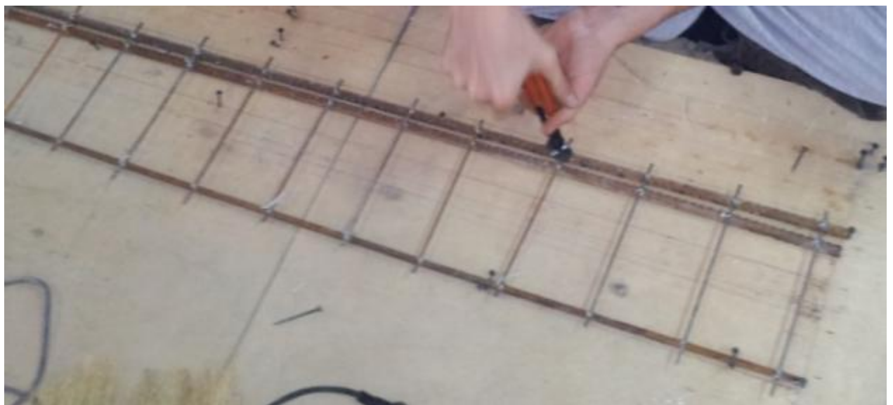
Рисунок 3.11 – Соединение элементов каркаса вязальной проволокой
