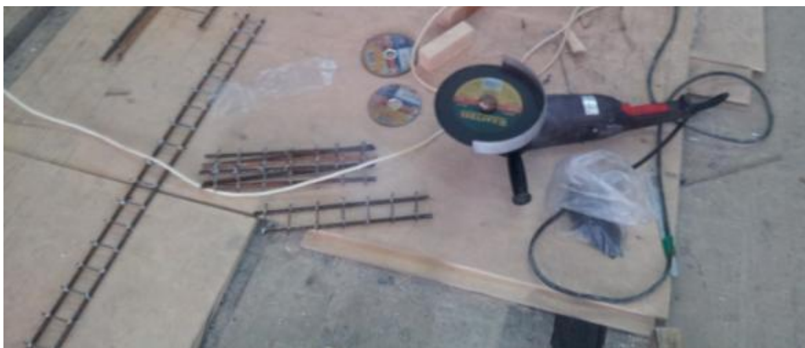
Рисунок 3.13 – Плоский каркас для армирования торцевого ребра плиты
