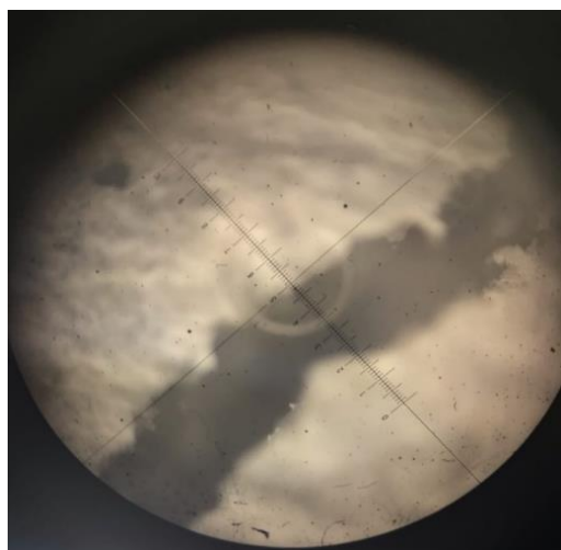
Рисунок 3.24 – Измерение ширины раскрытия трещин
