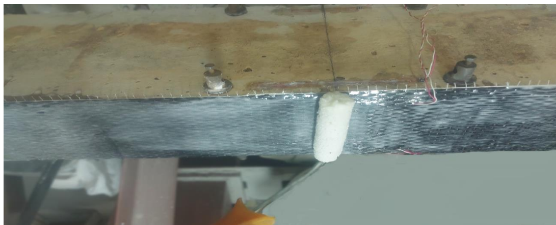
Рисунок 3.35 – Процесс укладки углеродного композита на нижнюю поверхность образцов
