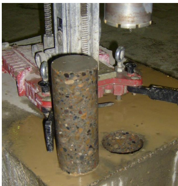
Рисунок 2.7 – Выпиленный из бетонной конструкции керн (цилиндр)
