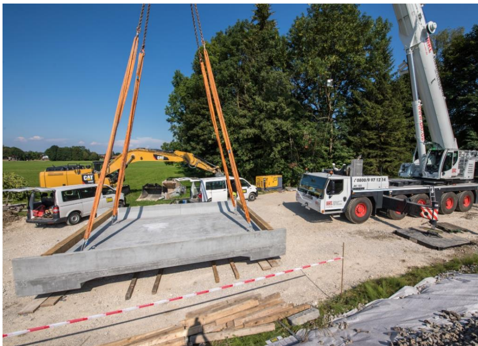
Рисунок 1.3 - Процесс монтажа плиты моста через Дюрнбах
