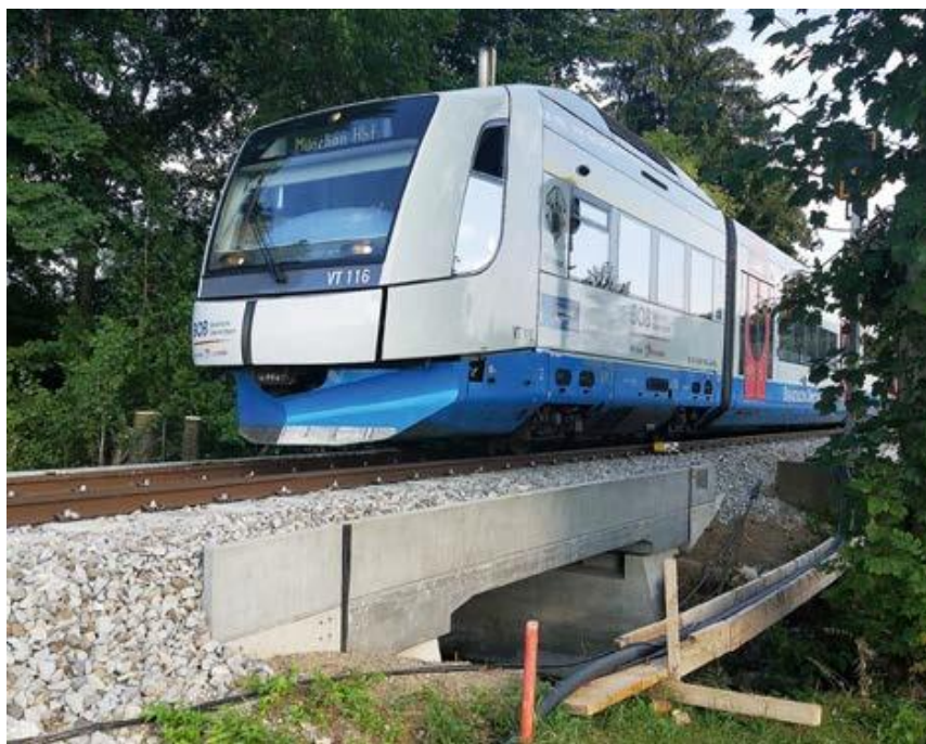
Рисунок 1.2 - Железнодорожный мост через Дюрнбах, Германия
