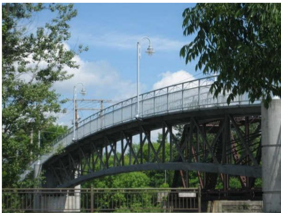
Рисунок 1.1 - Пешеходный мост из высокопрочного сталефибробетона в г. Шербрук, Канада
